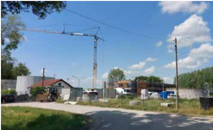
Preisanstieg bei der Sanierung der Windener Kläranlage: der Gemeinderat hat auf der letzten Sitzung zahlreiche Nachträge gebilligt.
